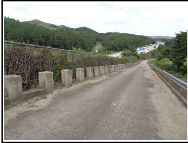
【그림 5.3.1】 상부자연사면 전경
