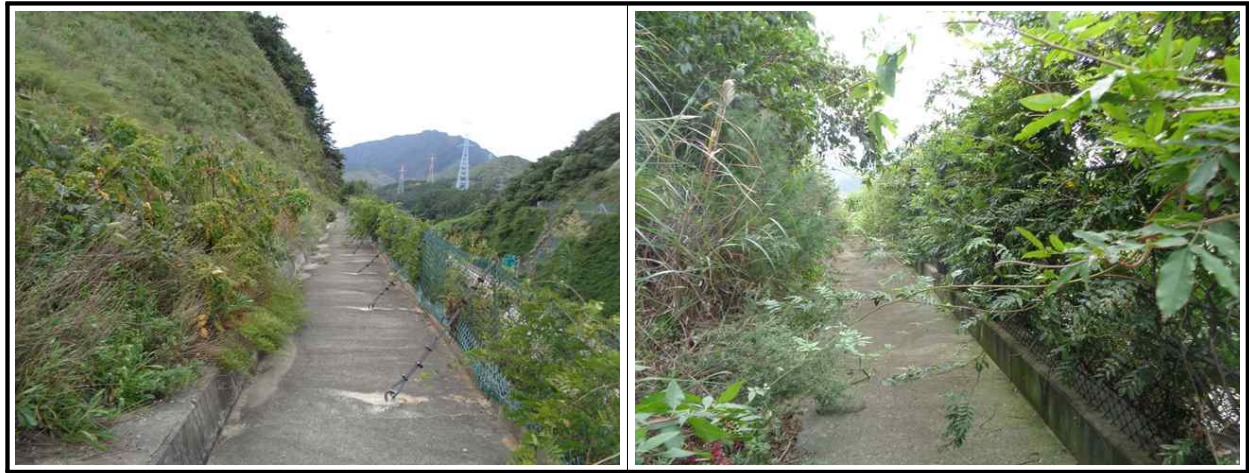
【그림 5.3.3】 배수시설 전경
